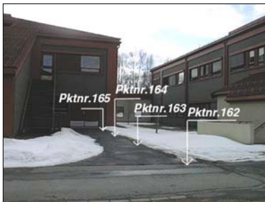
Punktnummer: 162,163,164,165 Bilderretning: Mot Str-Sørvest Type merke : Asfalspiker Bildedato : 12.04.2000
